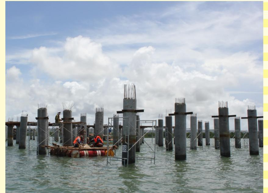
konstruksi jalan tol tersebut adalah pada pemilihan material beton sebagai penopang jalan tol secara keseluruhan.
